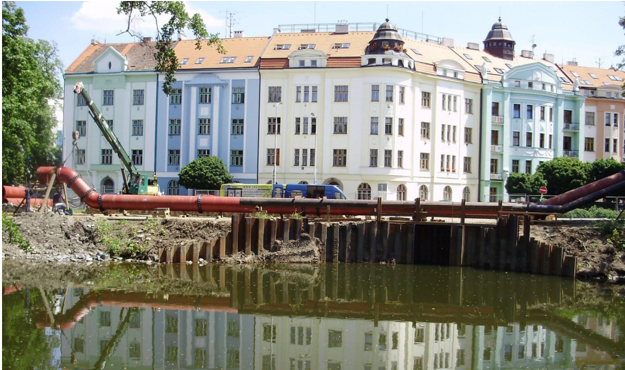
Shybka – celkový pohled
