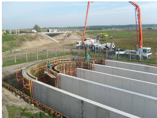
betonáž vnitřního oblouku
